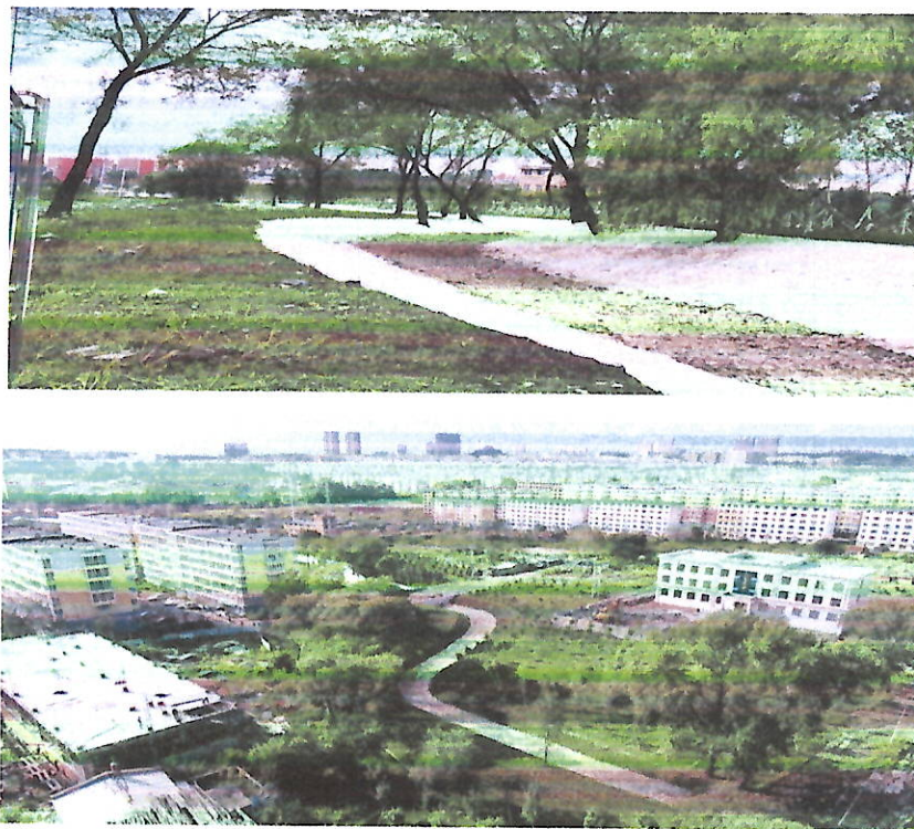
大陆煤泥沟治理后现状照片
