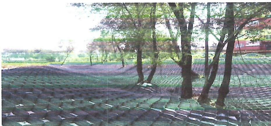
南大营沟治理后现状照片
